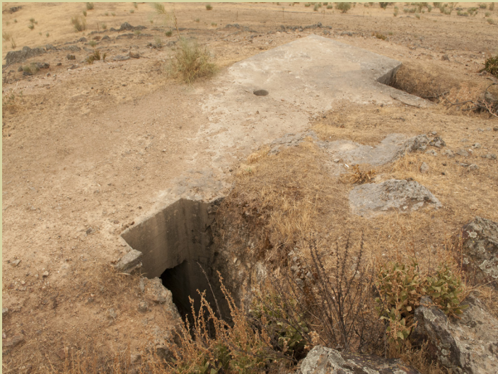
Refugio antiaéreo junto a uno de los búnkeres
