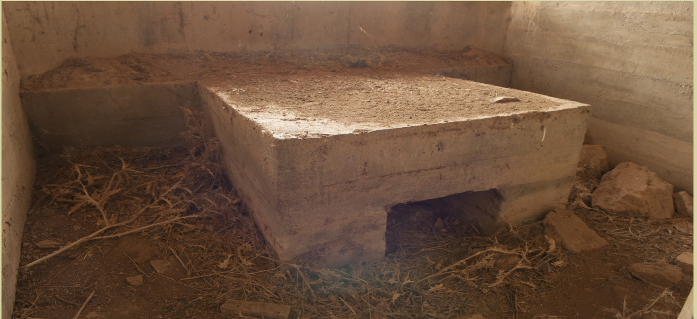
Espacio para la ametralladora en el interior de un búnker
